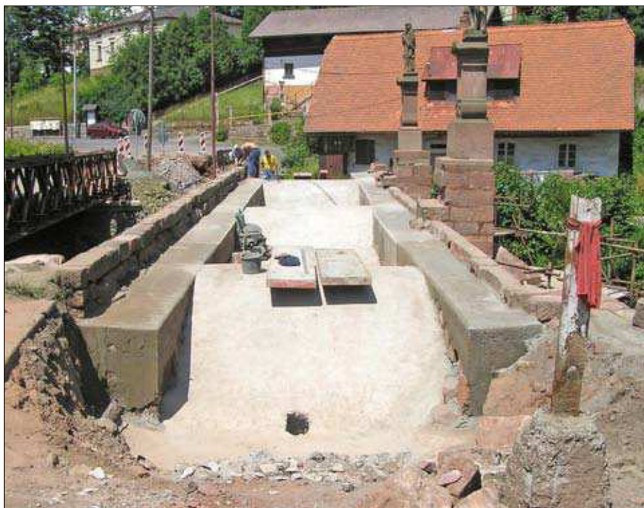
Rubová přízdívka parapetů mostu (foto Tomáš Kesner)
