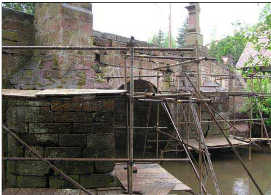
Stav mostu před zahájením stavebních prací – detail parapetní zdi a pilířů (foto Tomáš Kesner).
