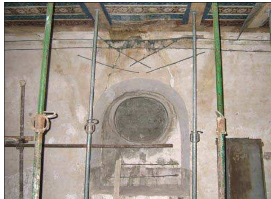
Provisorí podepření stropu.
