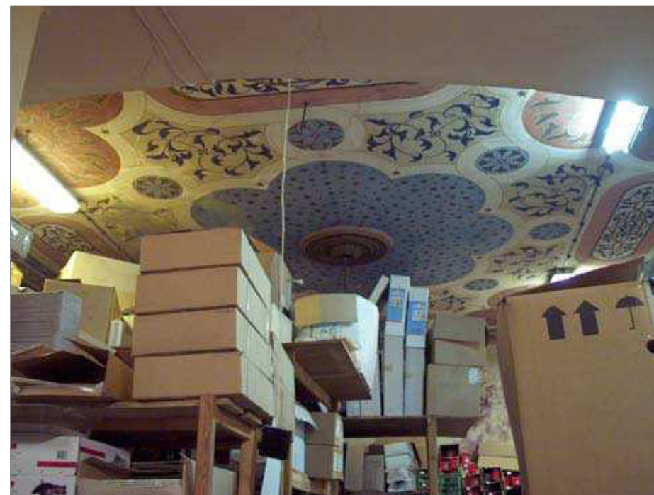
Strop synagogy před zahájením obnovy.
