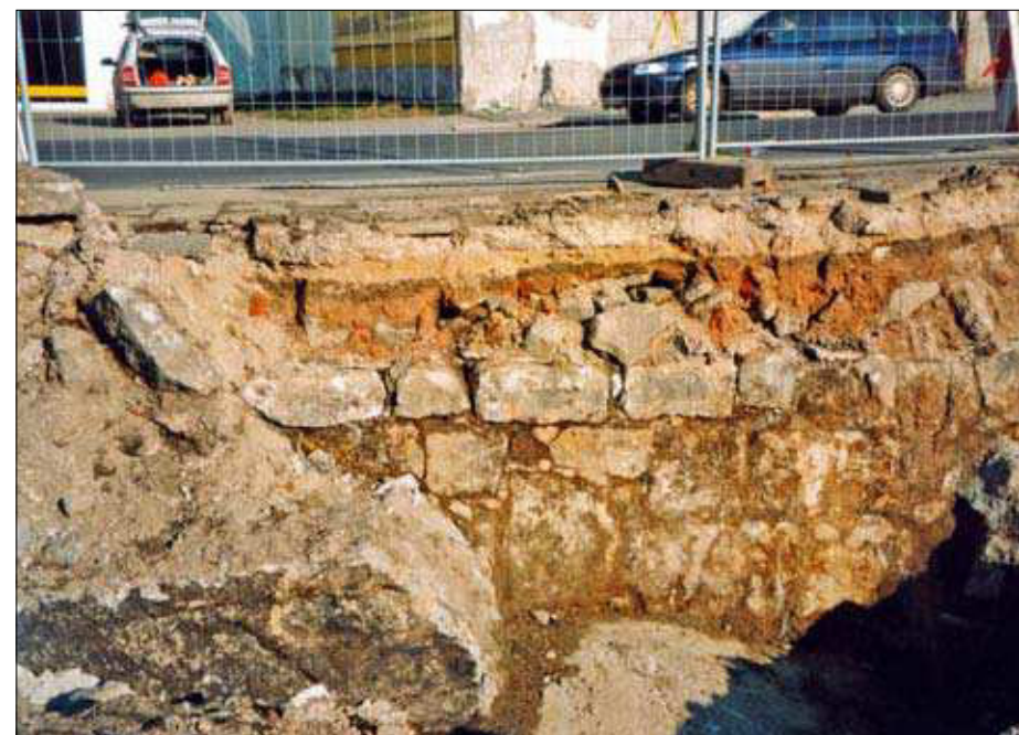
4. Základové zdivo Stöhrůvy textilní továrny podél třídy Dr. M. Horákové, obnažené při stavbě Kauflandu v březnu roku 2007.
