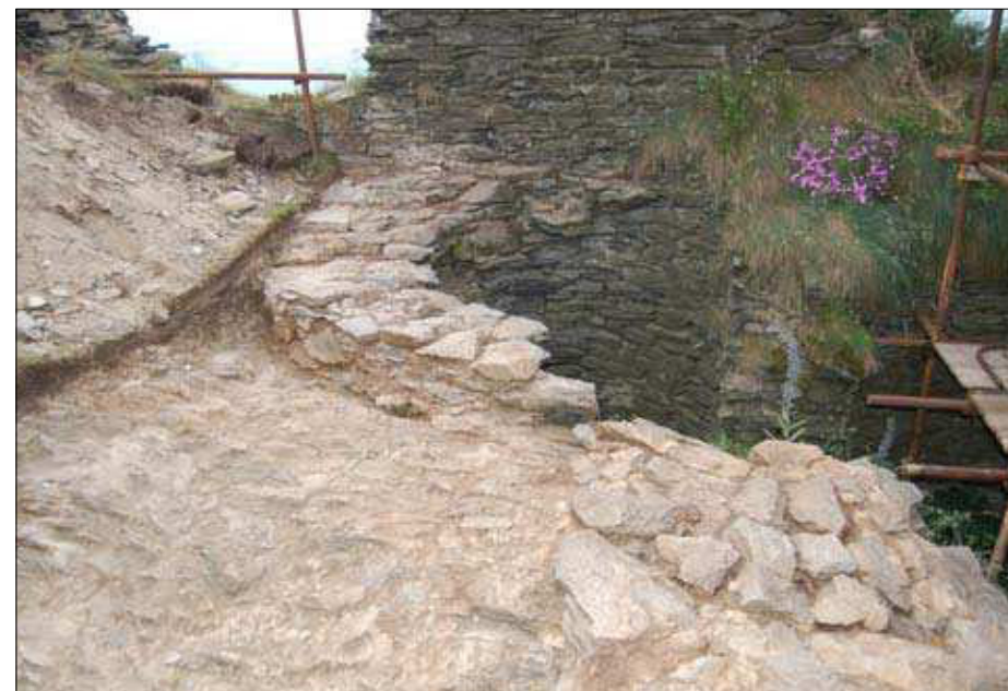
Obr. 3: Manský palác, odhalená koruna zdiva schodišťové věže. Foto Renata Tišerová.
