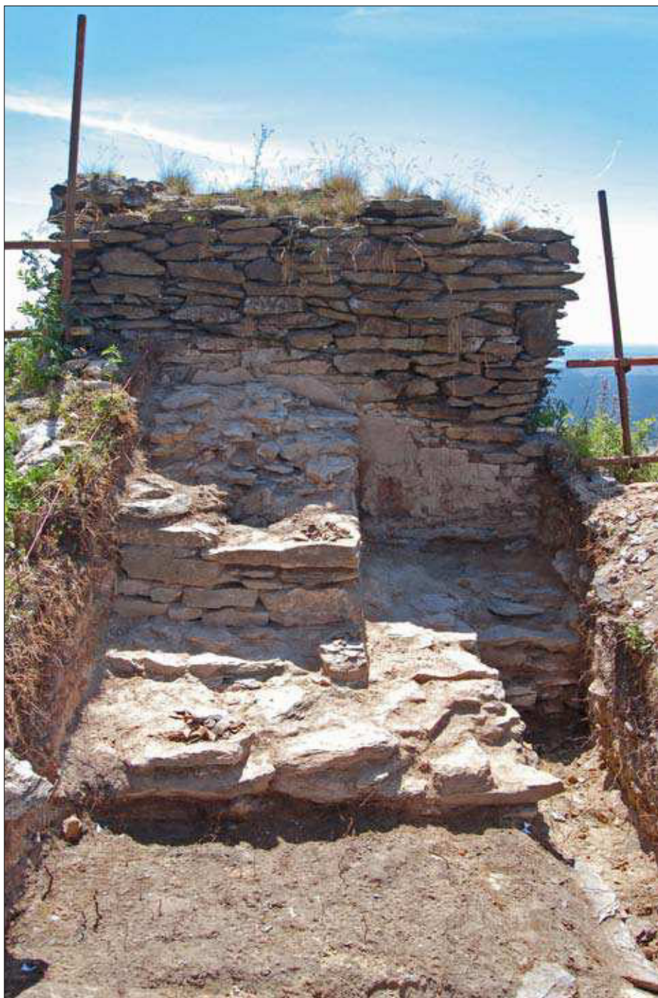
Obr. 4: Manský palác, těleso dýmníku se zachovanými relikty omítek. Foto Renata Tišerová.
