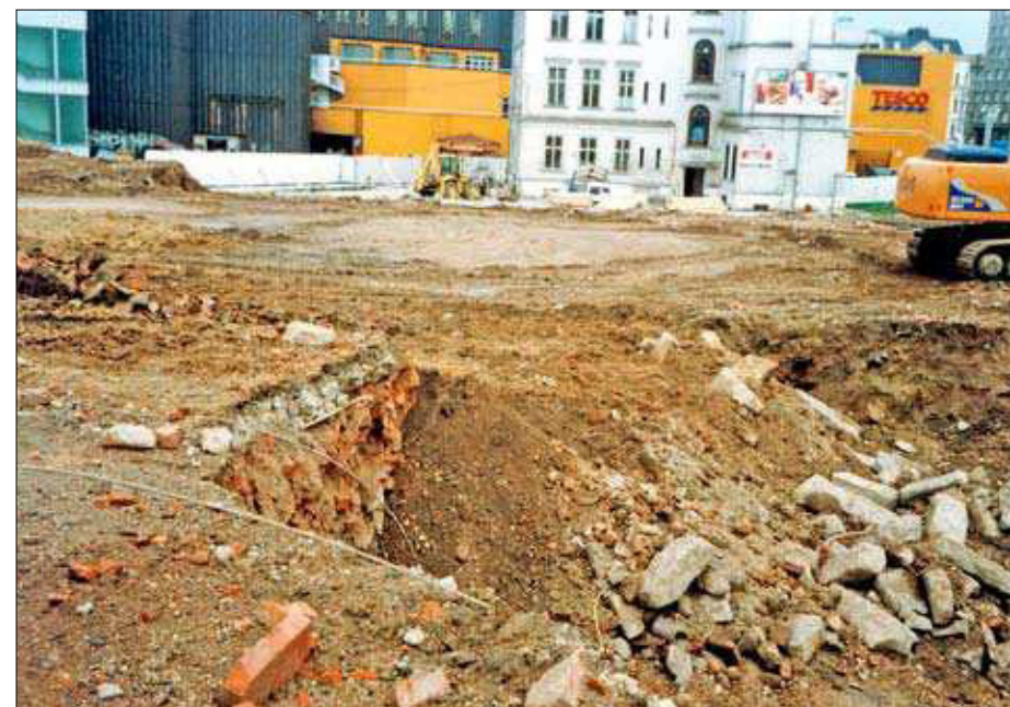
7. Detail žulových základových kvádrů a překladů z destrukční zásypové vrstvy z původní Demuthovy továrny.
