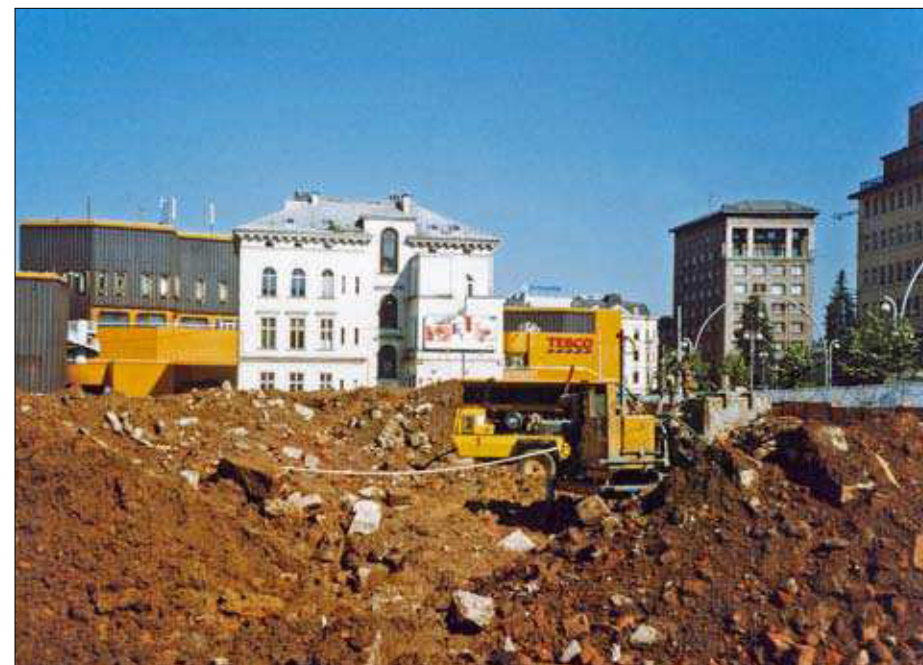
6. Likvidace destrukčních vrstev staré zástavby v centru staveniště Fora v červnu roku 2006.
